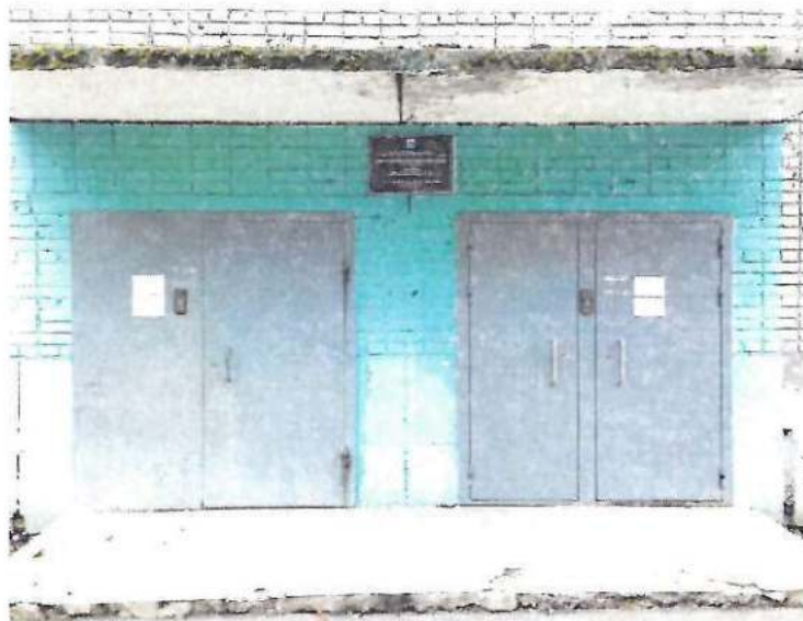
Фото №7 Вход № 2 в здание
