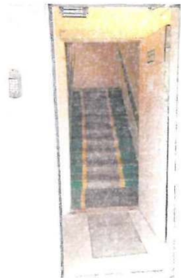
Фото № 13 Тамбур №2 и дверь внутренняя (Вход № 1)
