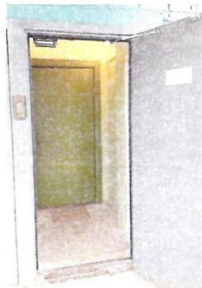
Фото № 15 Тамбур №2 и дверь внутренняя (Вход № 2)
