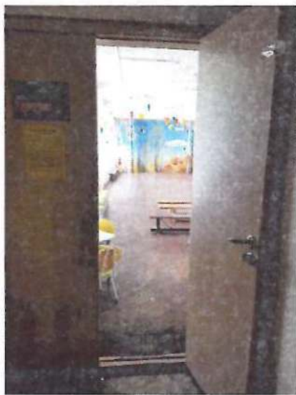
Фото № 18 Дверь внутри здания
