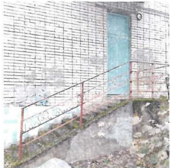
Фото № 19 Пути эвакуации
