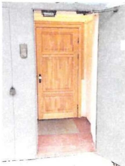
Фото № 12 Тамбур №1 и дверь внутренняя(Вход № 1)
