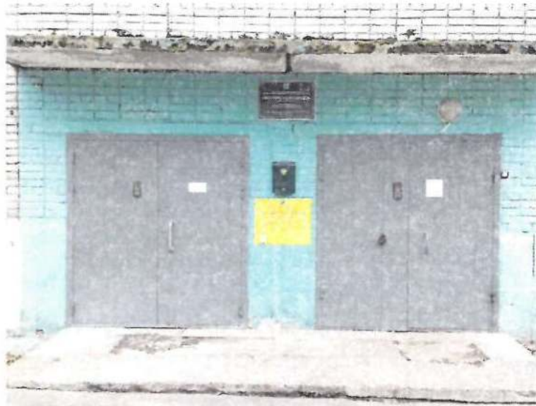
Фото № 6 Вход №1 в здание
