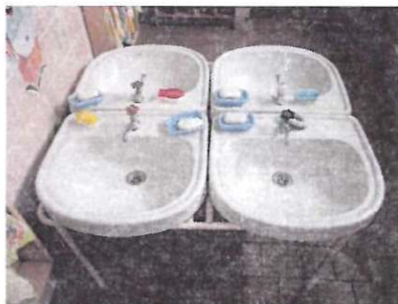
Фото №26 Туалетная комната
