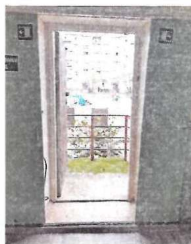
Фото № 21 Пути эвакуации
