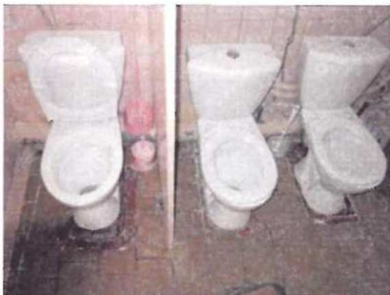
Фото № 25 Туалетная комната
