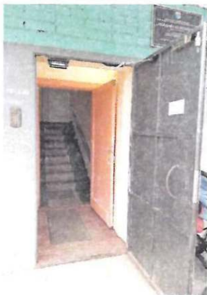
Фото № 14 Тамбур №1 и дверь внутренняя(Вход № 2)
