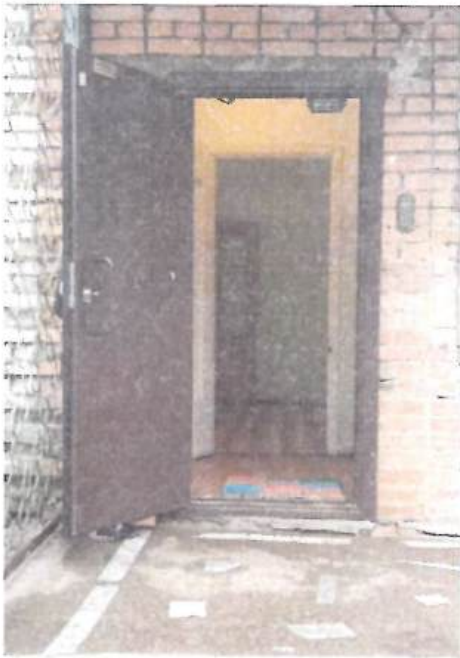
Фото № 10 Входная дверь (вход № 2)
