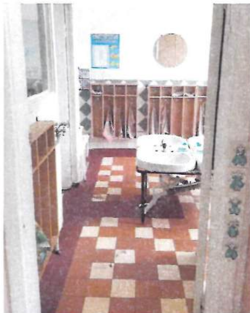
Фото № 27 Вход в туалетную комнату
