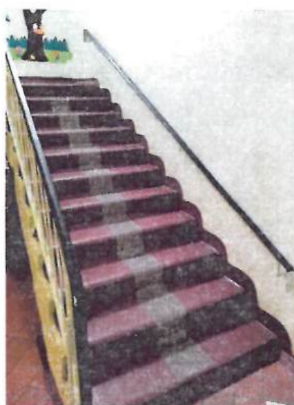
Фото № 17 Лестница внутренняя (межэтажная)
