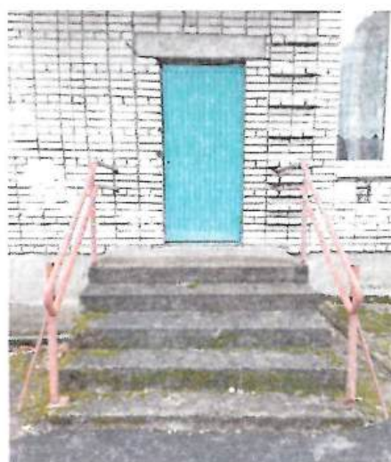
Фото № 21 Пути эвакуации
