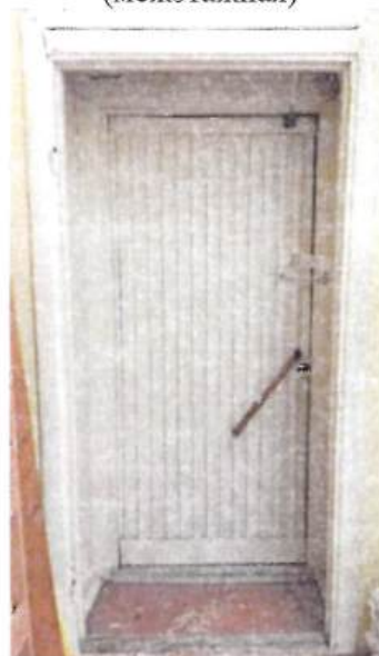
Фото № 19 Пути эвакуации
