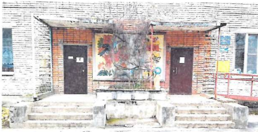
Фото № 5 Вход № 1 в здание (входная площадка и лестница наружная)
