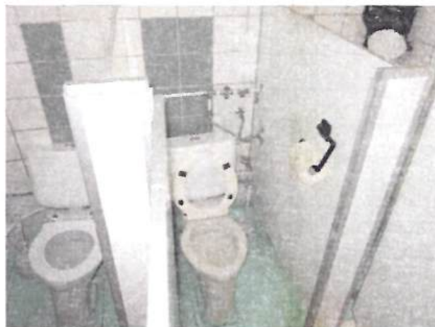
Фото № 29 Туалетная комната
