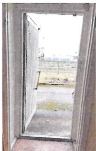
Фото № 20 Пути эвакуации
