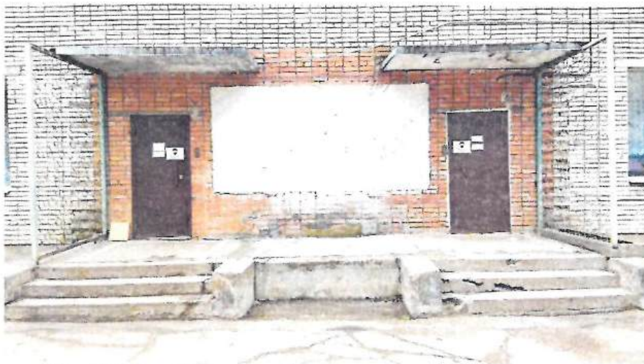
Фото № 6 Вход № 2 в здание (входная площадка и лестница наружная)
