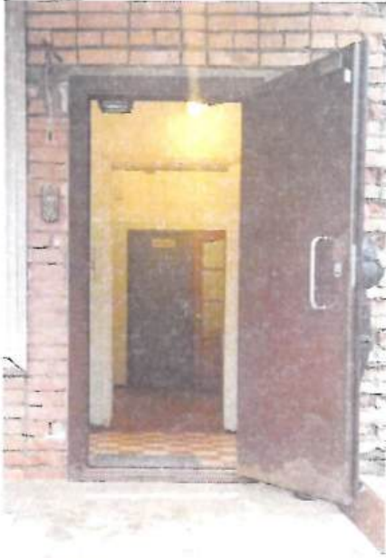
Фото № 8 Входная дверь (вход № 1)
