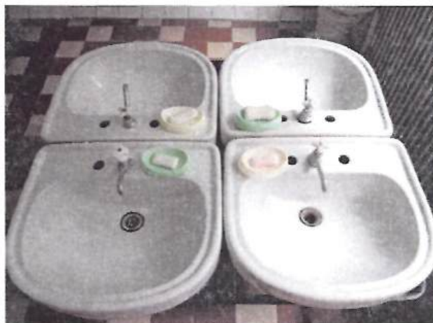
Фото № 28 Туалетная комната
